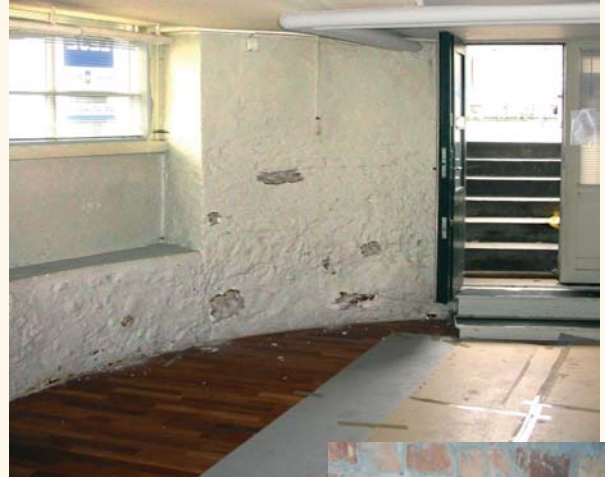
Fugt og saltskadedet væg
