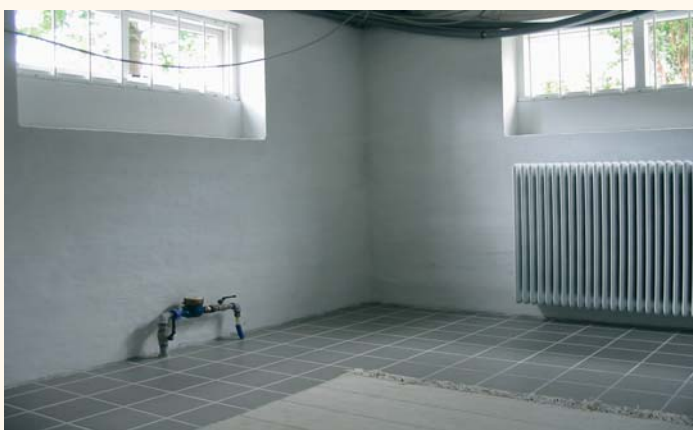
Færdig tør kælder
